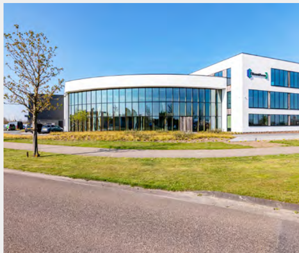
Het nieuwe bedrijfspand van Different Doors is het eerste bedrijfsgebouw in Nederland dat aan de energie-eisen van 2050 voldoet.
