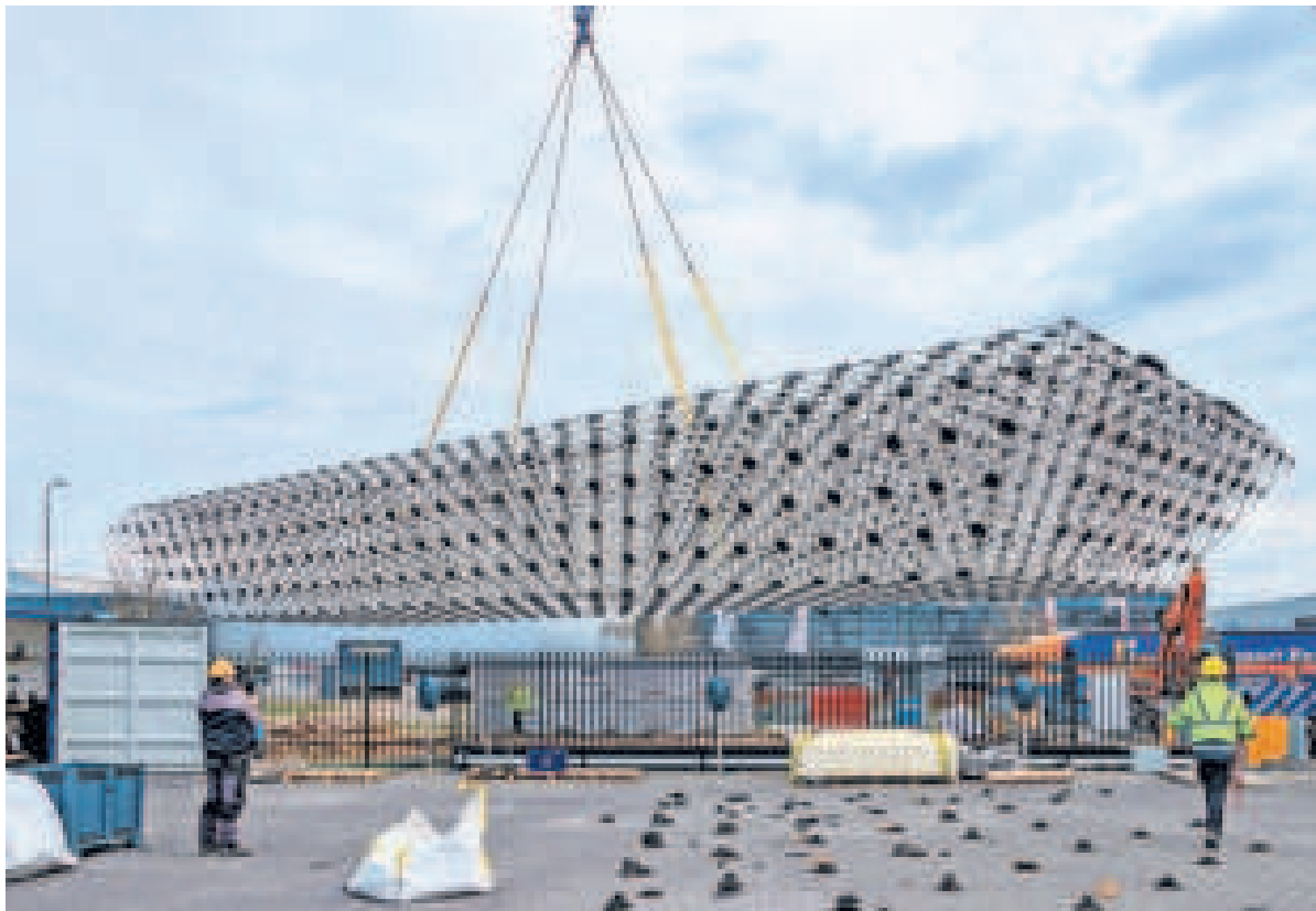
▲ Different Doors gebruikt een buffer met water van 580 kubm. Die bestaat uit een aluminium frame ('spaceframe') dat onder de grond wordt geplaatst. Hier hangt-ie nog in de takels. FOTO DIFFERENT DOORS
